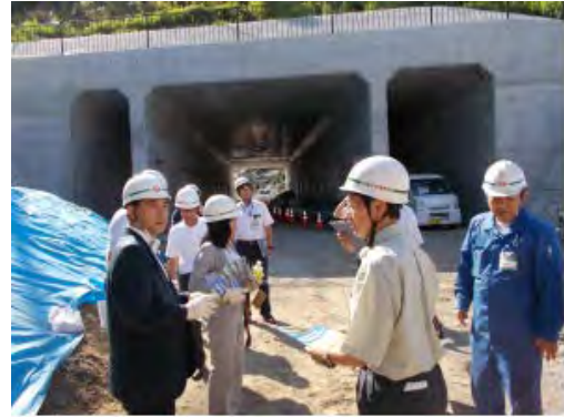
市道戸塚第420号線宮之谷トンネルについて現場視察を行う監査委員
