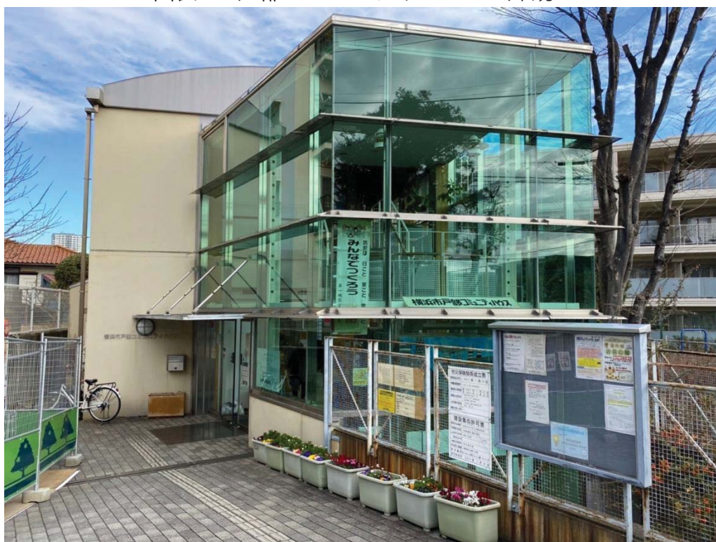
図表11 戸部コミュニティハウスの外観
