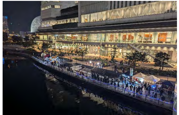
【市庁舎前の河川空間の活用】
