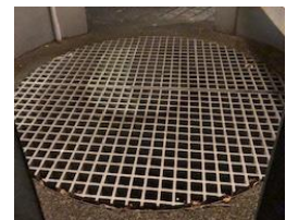
海の音のするマンホール (みなとみらいコース)
