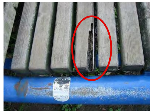
▲ 座板の腐食
