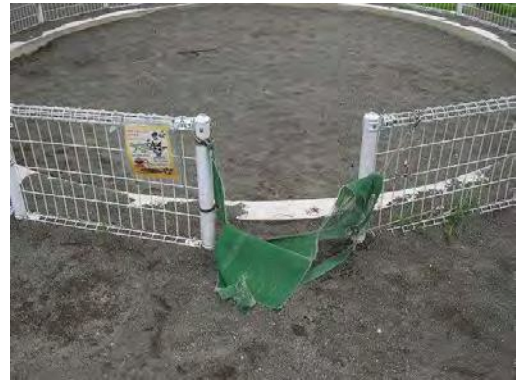
▲ 砂場柵入口の破損
