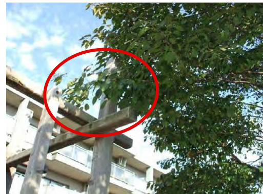
▲ 樹木の枝が支障となっている
