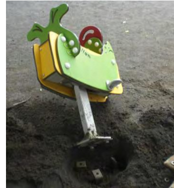
▲ ボルト欠損、アンカープレート破断
