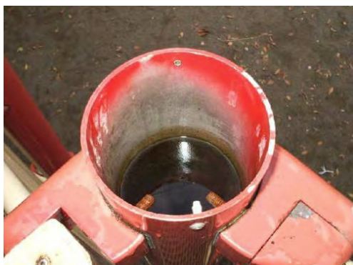
▲ 柱頂部キャップ欠落
