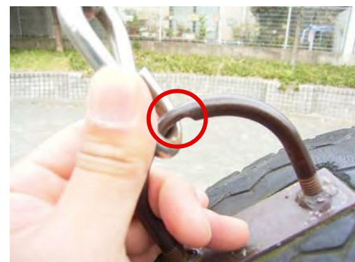
▲ タイヤ取付リングの摩耗
