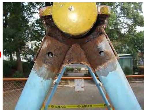
▲ ブランコ支柱継ぎ手金具取り外し状況
