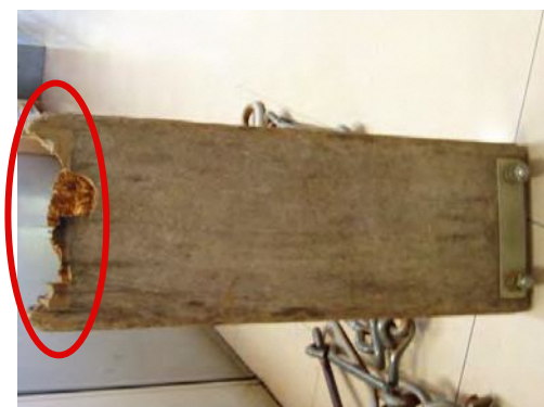
▲ 座板の腐食
