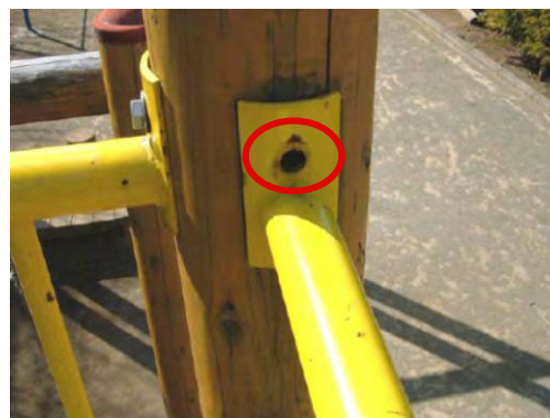
▲ 安全柵取り付け金具の欠落
