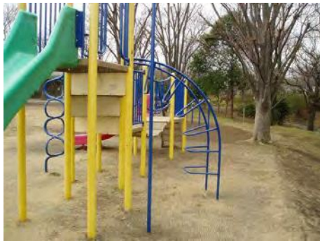
▲ 部分的な使用禁止措置の事例
