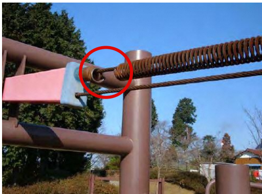
▲ 緩衝部（スプリング）の破損
