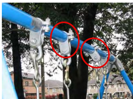
▲ 吊金具のずれ
