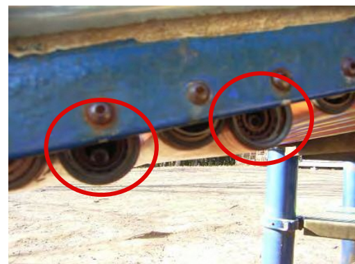
▲ ローラーすべり台のローラー破損
