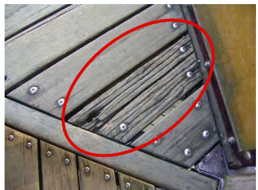
▲ 床材の腐朽
