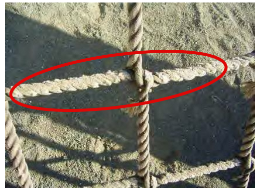
▲ ネットの破損・摩耗
