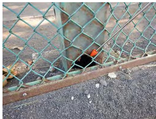
▲ 高尺フェンス 支柱穴
