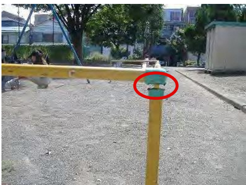
▲ ブランコ安全柵の継手金具の割れ
