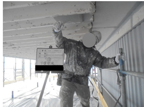
外壁屋根塗装工事
