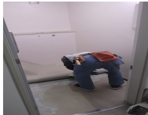
内装改修工事
