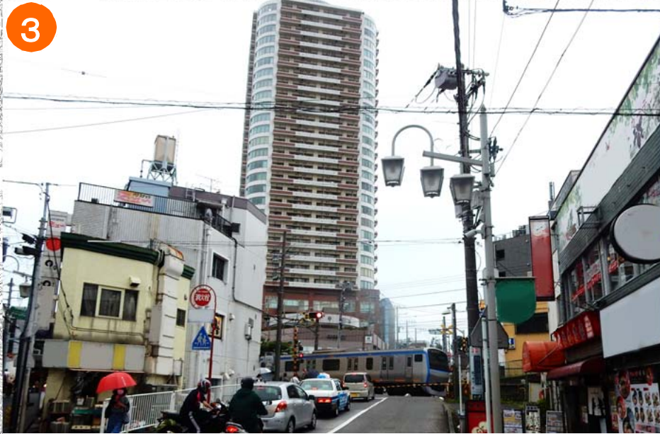
鉄道による地域の分断状況
