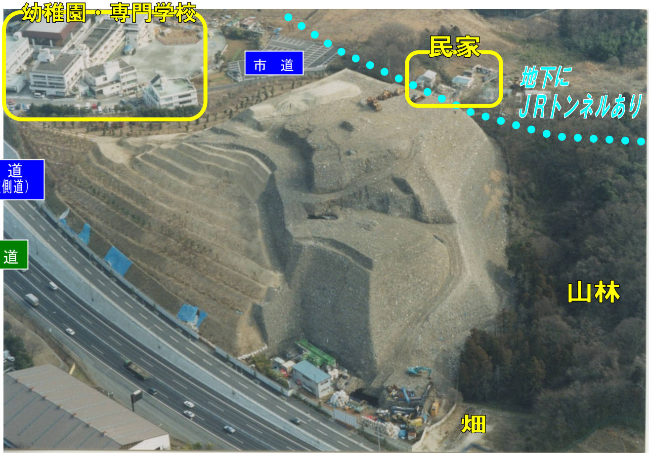
図－1. 2 改善工事前の処分場周辺の状況
