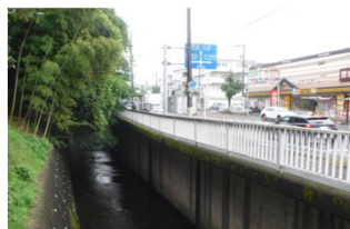
緊急輸送路に隣接した護岸(特殊堤)
