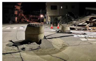
マンホール浮上(輪島市)
