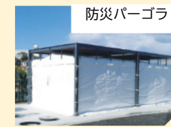
<防災設備の例>
