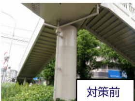
落橋防止装置の設置
