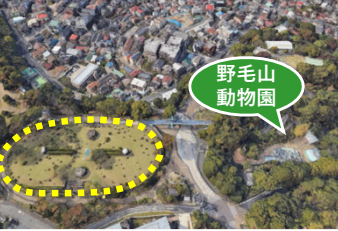
旧野毛山配水池
