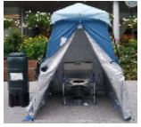
マンホールトイレ
