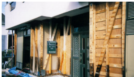
木造家屋耐震補強工事の例
