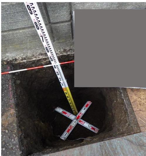
建替える防犯灯は、市の仕様に則り、鋼管ポール基礎として直径 50cm のものを設置します。
